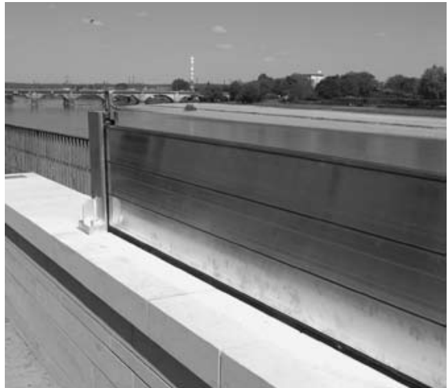
Bild 2: Tafelstandort 8 vor neu errichteter Hochwasserschutzmauer (links) für die Dresdner Altstadt als optisch ansprechende, mit Sandstein verkleidete Stahlbetonmauer, die bei Hochwasser mit mobilen Aufsätzen (rechts) erhöht werden kann (Fotos: K. Grunewald)
