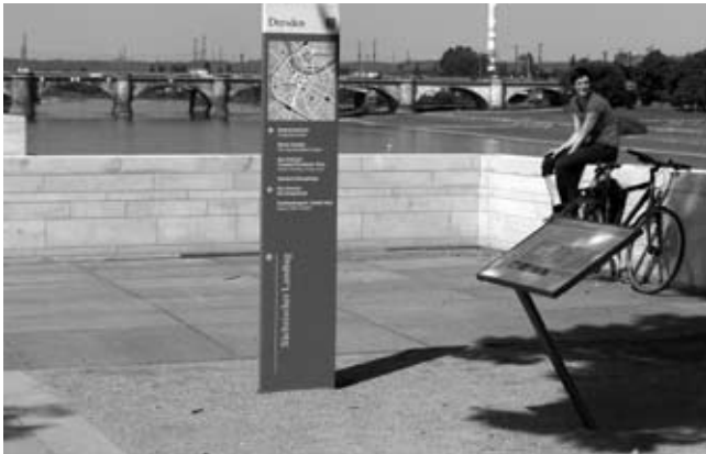
Bild 2: Tafelstandort 8 vor neu errichteter Hochwasserschutzmauer (links) für die Dresdner Altstadt als optisch ansprechende, mit Sandstein verkleidete Stahlbetonmauer, die bei Hochwasser mit mobilen Aufsätzen (rechts) erhöht werden kann (Fotos: K. Grunewald)
